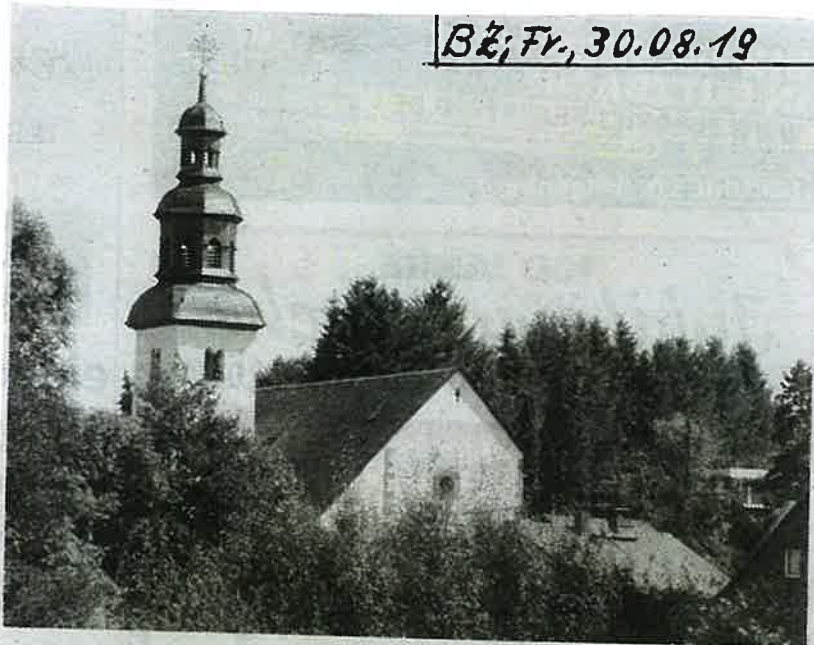
In Trais-Münzenberg geht die evangelische Kirche in ihren ältesten Teilen auf die Zeit um 1100 zurück. 1200 wurde das nördliche Seitenschiff errichtet. 1889 - vor 130 Jahren - erfolgte ein eingreifender Umbau.
