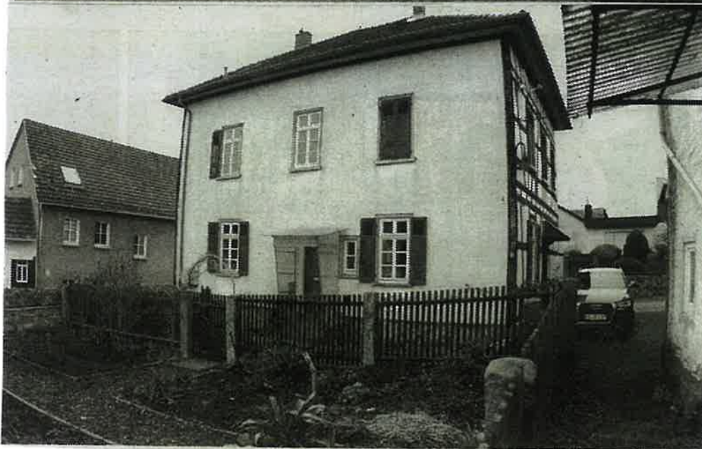
MÜNZENBERG. Das Münzenberger „Doktorhaus“ im Steinweg - auf unserer Bilderleiste in einer Straßen- und Hofansicht - erhält einen Anbau und wird im Inneren umgebaut.
