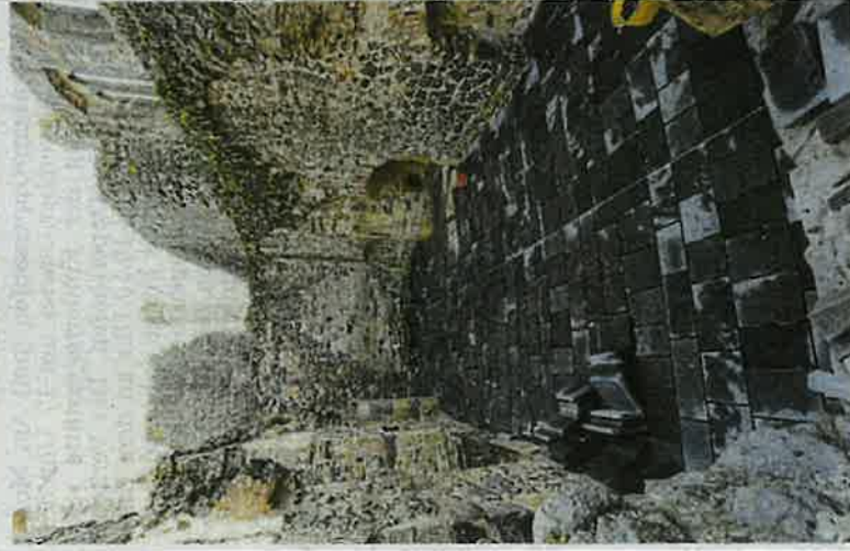
Der Boden der Kapelle war undicht. Die Abdichtung ist erneuert worden. Zudem werden Basaltsteine verlegt.
